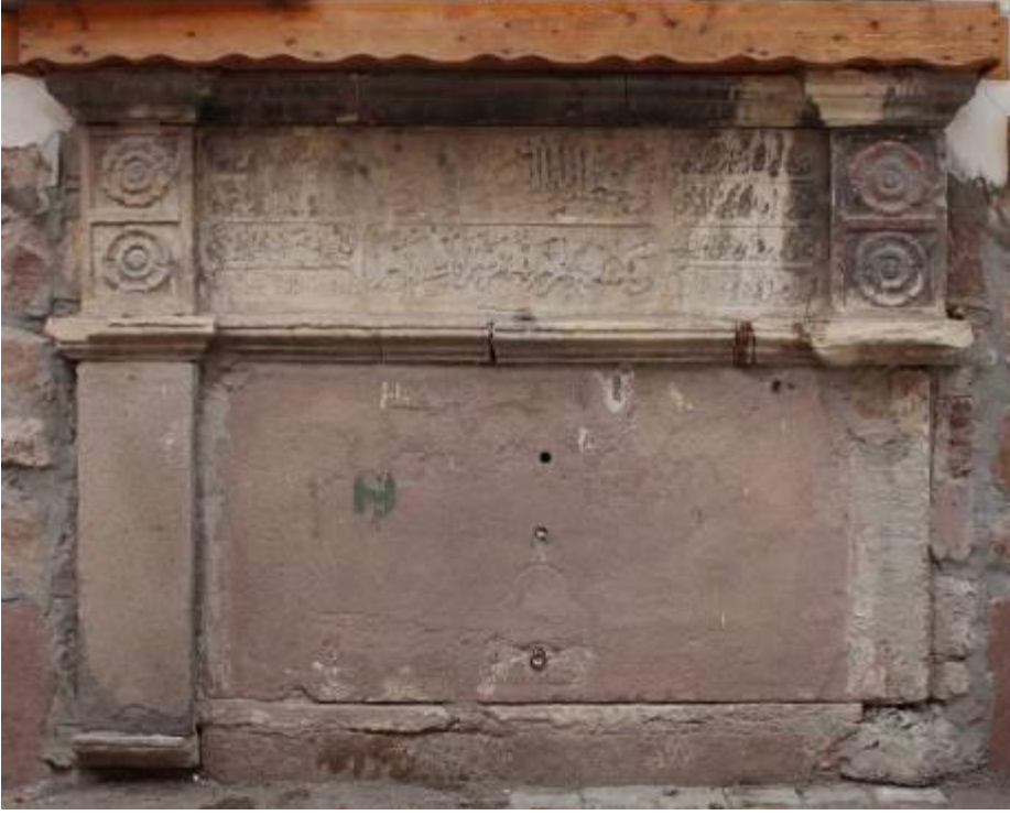
Fotoğraf 18: Çamaşırhane Çeşmesi cephesi.
