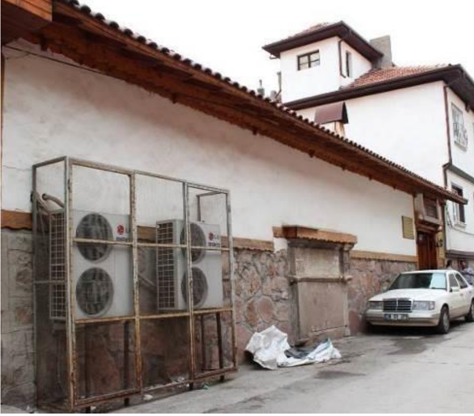
Fotoğraf 7: Güney cephesi.
