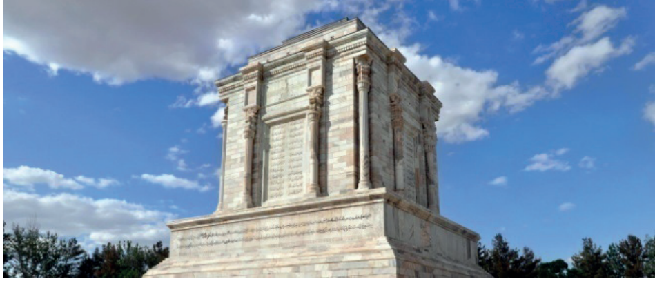
G. 11. Firdevsi'nin Mezarı (1929-34) (Arash Kazemivand Niar), Mimar: Kerim Tâhîrzâde (Vahid Ghobadian, a.g.e)
