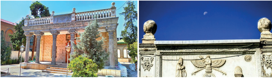
G. 1. (Solda) Adrian Ateşkedesi (1914) Genel Görünüşü ve (Sağda) Cephesinde Kullanılan Furuher Simgesi (Arash Kazemivand Niar) Mimar: Anonim (Vahid Ghobadian, a.g.e)
