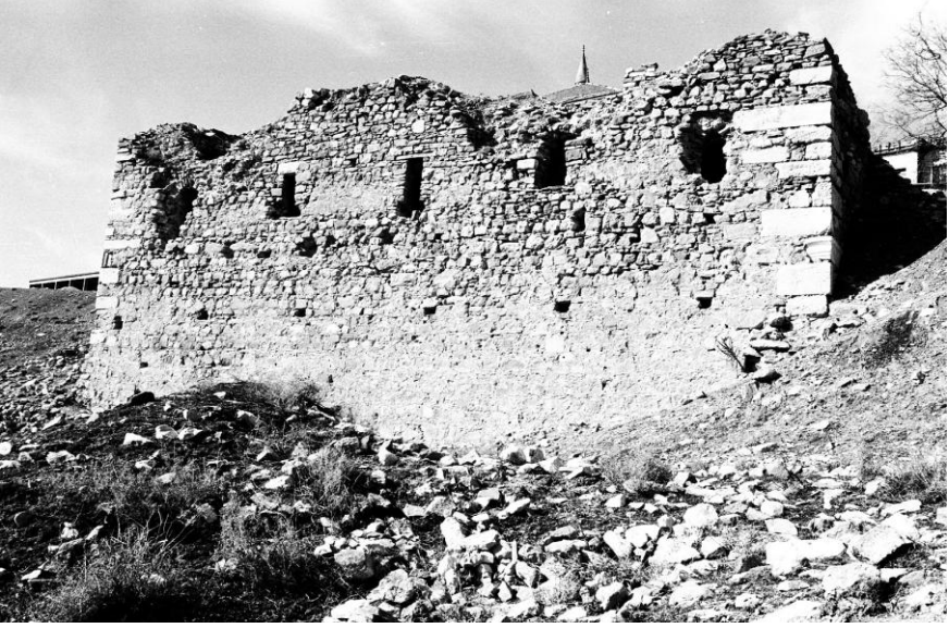
Levha 5. Medrese, Güney Cephe
