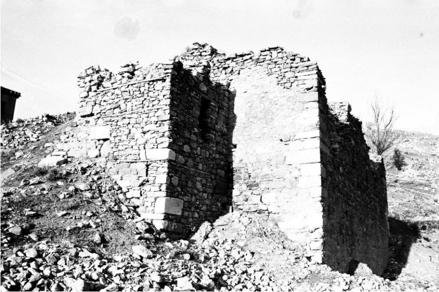
Levha 6. Medrese, Batı Cephe
