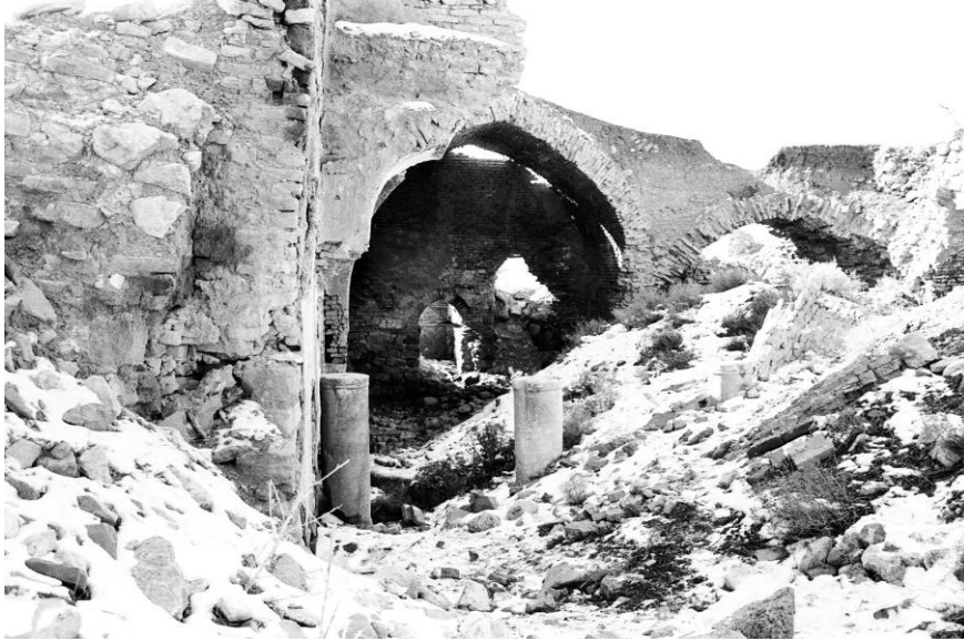
Levha 7. Medrese, Avlu, Genel Görünüm
