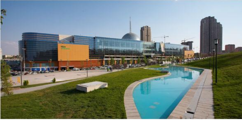
Resim 1. Panora Alışveriş Merkezi ve Panora Park Alanı, http://www.panora.com.tr/ , 2008
