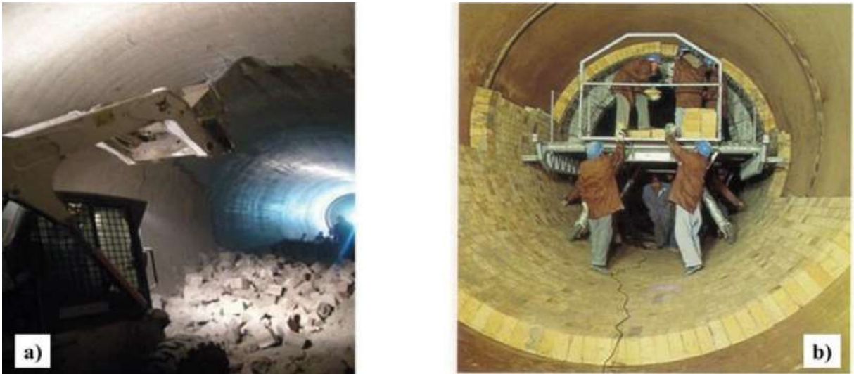
Şekil 7. Döner fırın tuğla revizyonu; a) tuğla söküm işleri ve b) tuğla örtümü
