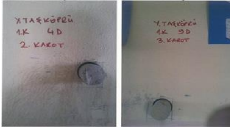
Şekil 3. Binadan karot numuneleri alınması
