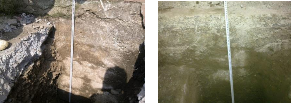
Şekil 2. Binanın dışından ve içinden açılan temel çukurları
