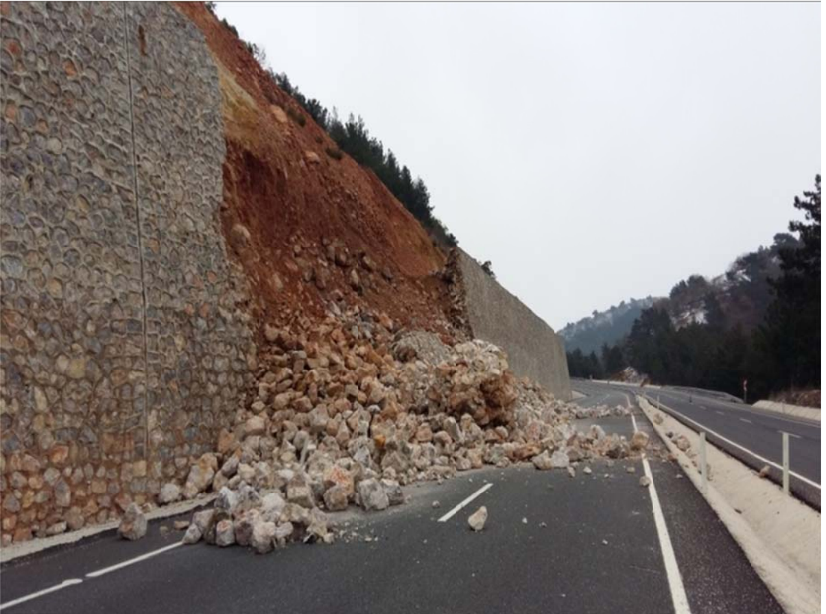
Foto 4: Yama dengesinin bozulması sonucunda byk miktarda malzeme istinat duvarını yıkarak yola tařmıřtır. Bitki rtsnn tahrip edilmesi de bunda nemli rol oynamaktadır (Balıkesir – Edremit Karayolu 60. Km, 2015).
