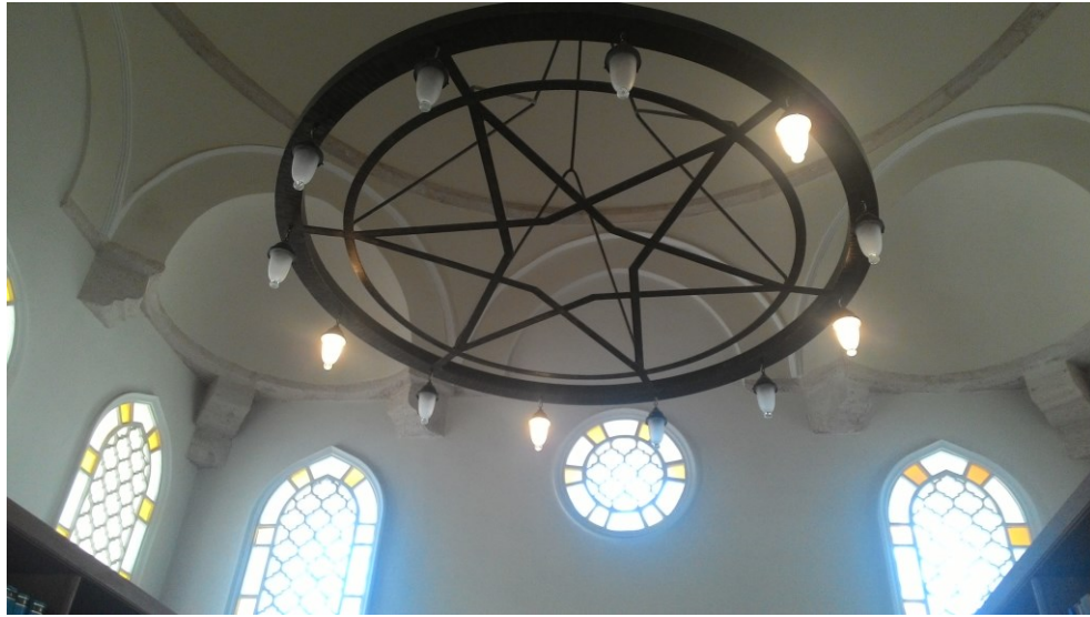
Fot.: 3 Medresenin sınıf bölümünün kubbesi ve iki tarafta tromplar ile revzenli tepe pencereleri (Fotoğraf yazara aittir).
