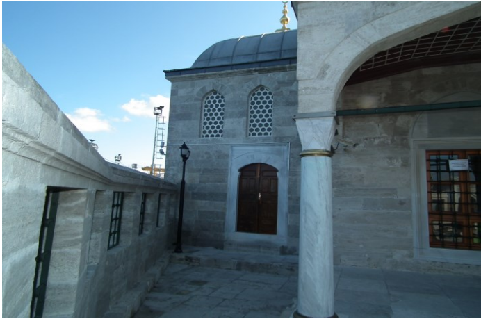
Fot.: 6 Şemsi Ahmed Paşa türbesi ve külliye duvarının sınırladığı açılı avlu (Fotoğraf yazara aittir).
