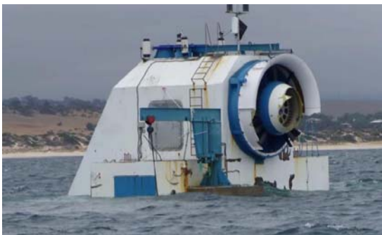
Şekil 1. Salınan su sütunu tipi dalga enerjisi dönüştürücü [3]
