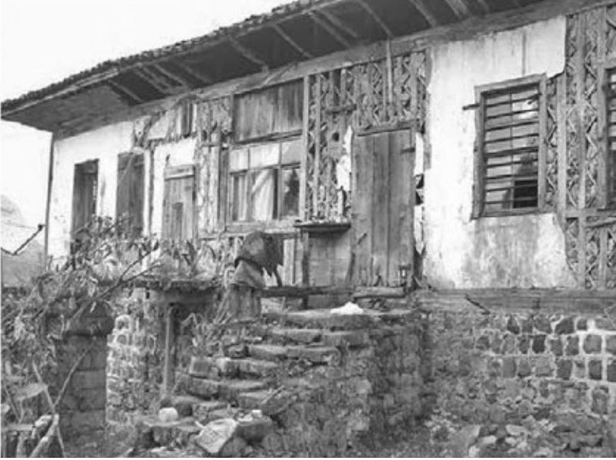
Şekil 18: Çakatura yapım sistemi (Güler ve Bilge 2013)
