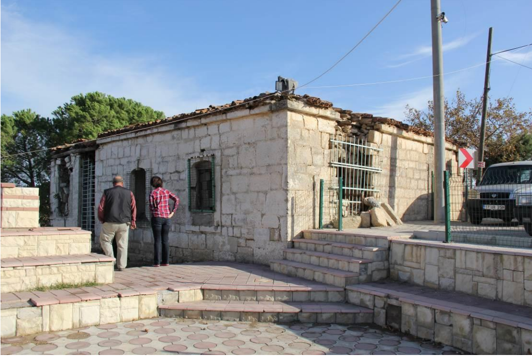
Res.29- Tevfikiye Köyü Camii, onarımdan önce.
