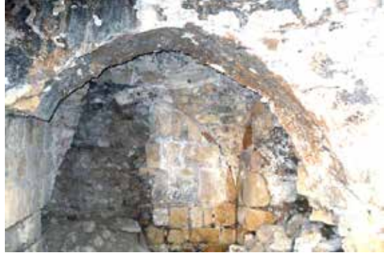
Fotoğraf 21: Sadak Köyü Hamam, sıcaklık kubbesinin giriş kısmı. Kubbeye giren kemerli kapı, taş ve tuğla malzemeyle yapılmıştır. (Ç. B. DİKMEN ve F. TORUK Arşivi )
