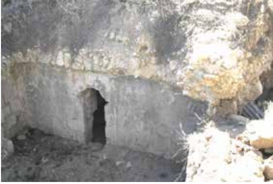
Fotoğraf 18: Sadak Köyü Hamam, ılık bölüme giren küçük bir kemerli kapı. Duvarlar taş ve tuğla malzemeyle kaplıdır. (Ç. B. DİKMEN ve F. TORUK Arşivi )
