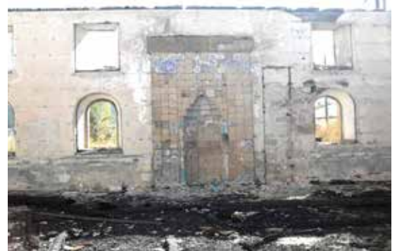
Fotoğraf 15: Sadak Köyü Cami Yangın Sonrası Güney Duvarı 2012, (Ç. B. DİKMEN ve F. TORUK Arşivi)
