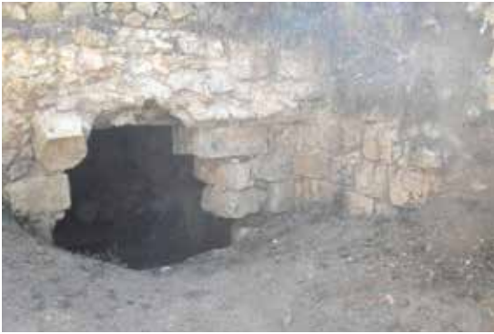
Fotoğraf 19: Sadak Köyü Hamam, halvetten sıcaklığa geçiş kapısı. Kapı, taş ve tuğla malzemeyle yapılmıştır. (Ç. B. DİKMEN ve F. TORUK Arşivi )
