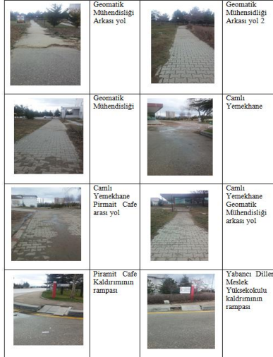
Şekil 4. (devam ediyor) Uygulama Alanındaki Durum Tespit Çalışmaları
