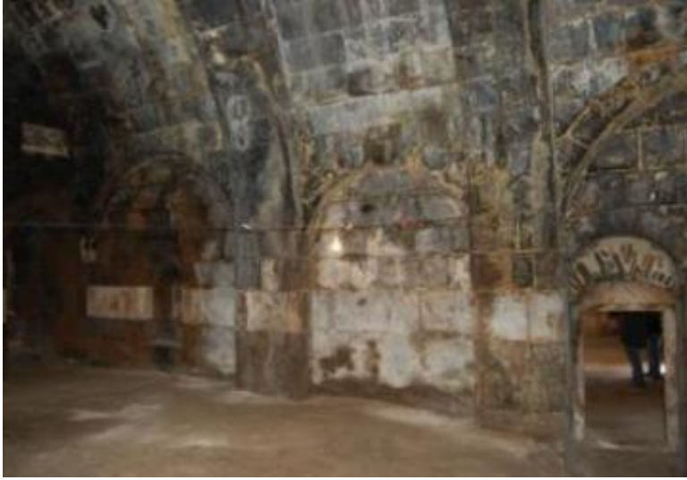
Foto. 8: Saint Croix Kilisesi, güney duvar
