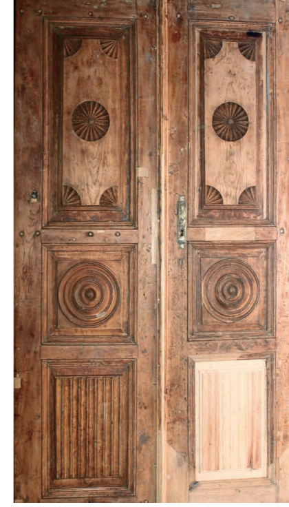
Bir 19.yy sonu kapısının otantikliği korunarak, çürüyen kısımların onarılması
