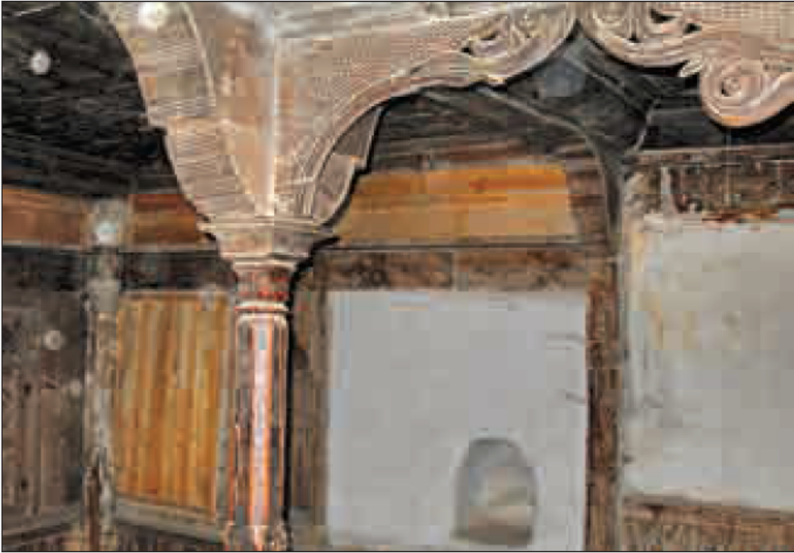
Fotoğraf 24: 1 No'lu Köy Odası Ahşap Taşıyıcı
