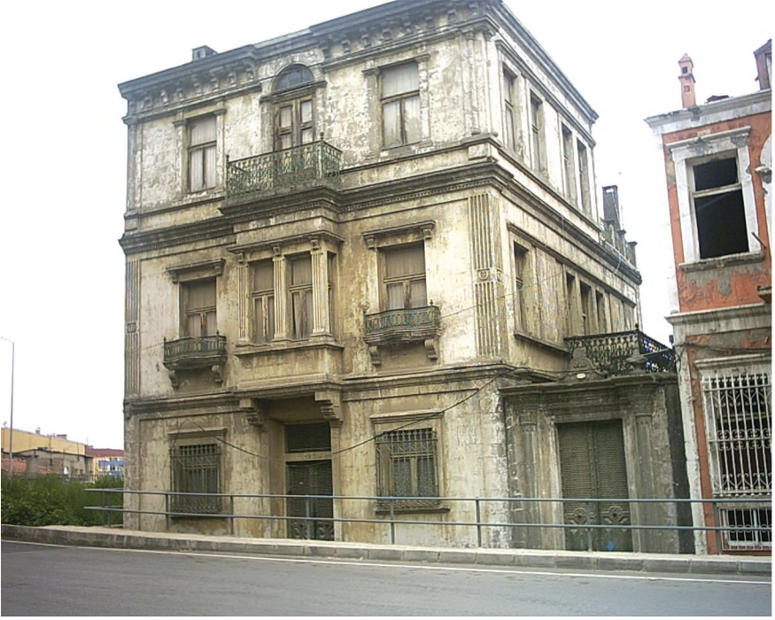
Resim 3. Eklektik Üsluplu Bir Trabzon Yapısı
