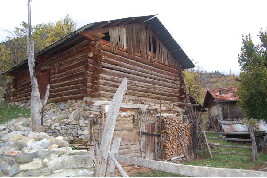
Resim 13. Kütüklerle yapılmış bir ahşap yığma servis yapısı
