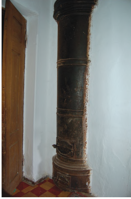
Resim 21. Tarihi Artvin Yapılarında sık rastlanan bir ısıtma sistemi olan, Peç.
