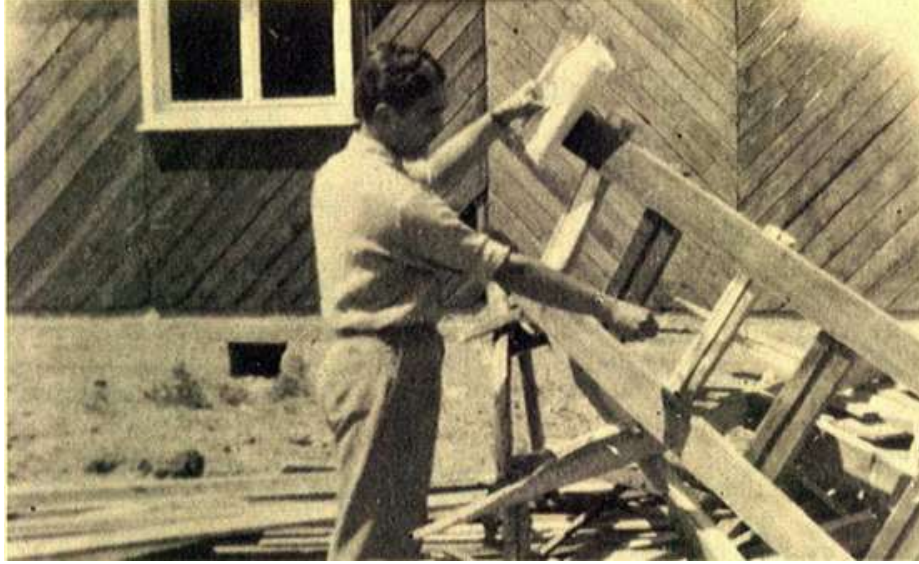
Fotoğraf 5: Arka kısımda çapraz tahtalar ile kaplanmış kurma ev inşaatı görülmektedir (Koyunoğlu, 1977, 22).
