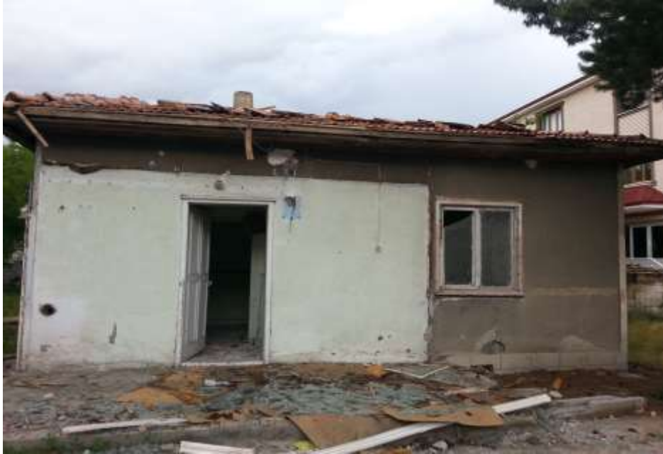
Fotoğraf 10: Yıkılmak üzere boşaltılan kurma evden bir görünüm.
