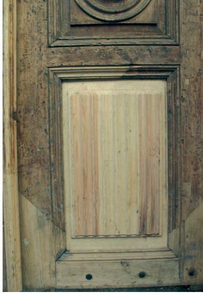
F.19: Ahşap yapı elemanında bütünleme örneği (KUDEB Ahşap Atölyesi, 2009)
