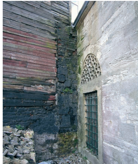
Resim 05, Bitişik parseldeki yapı Darülkurra'ya yaslanmıştır.
