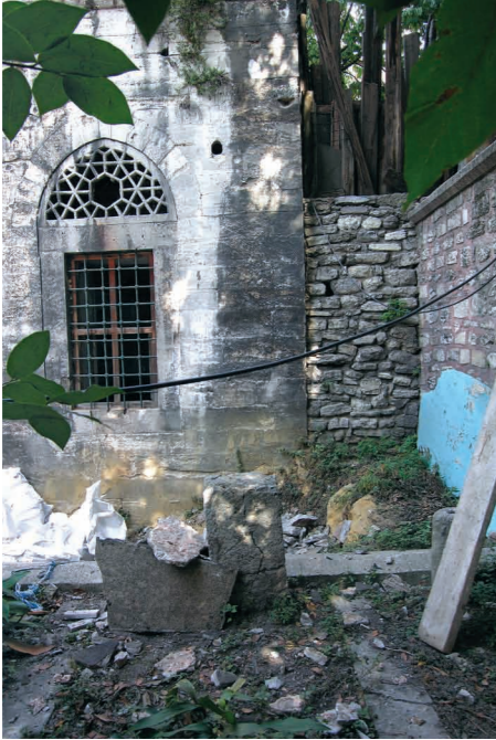
Resim 02, Bitişik parsel tarafından yapının arka tarafı doldurulmuştur.
