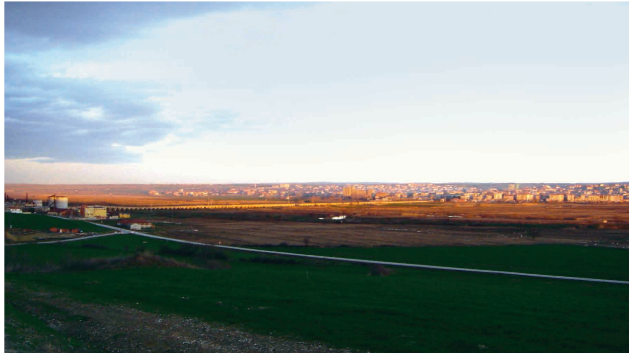
Resim 15: Edirne Uzunköprü de Ergene üzerine inşa edilmiş 1200 m. uzunluğundaki Uzunköprü.
