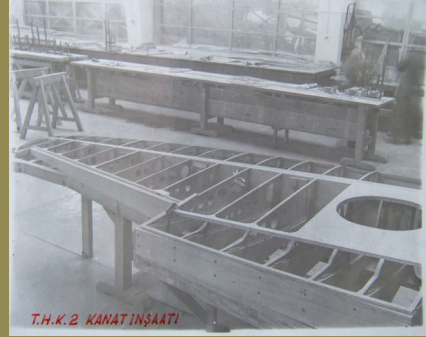
Ek-28:THK-2 Kanaat İnşaati
