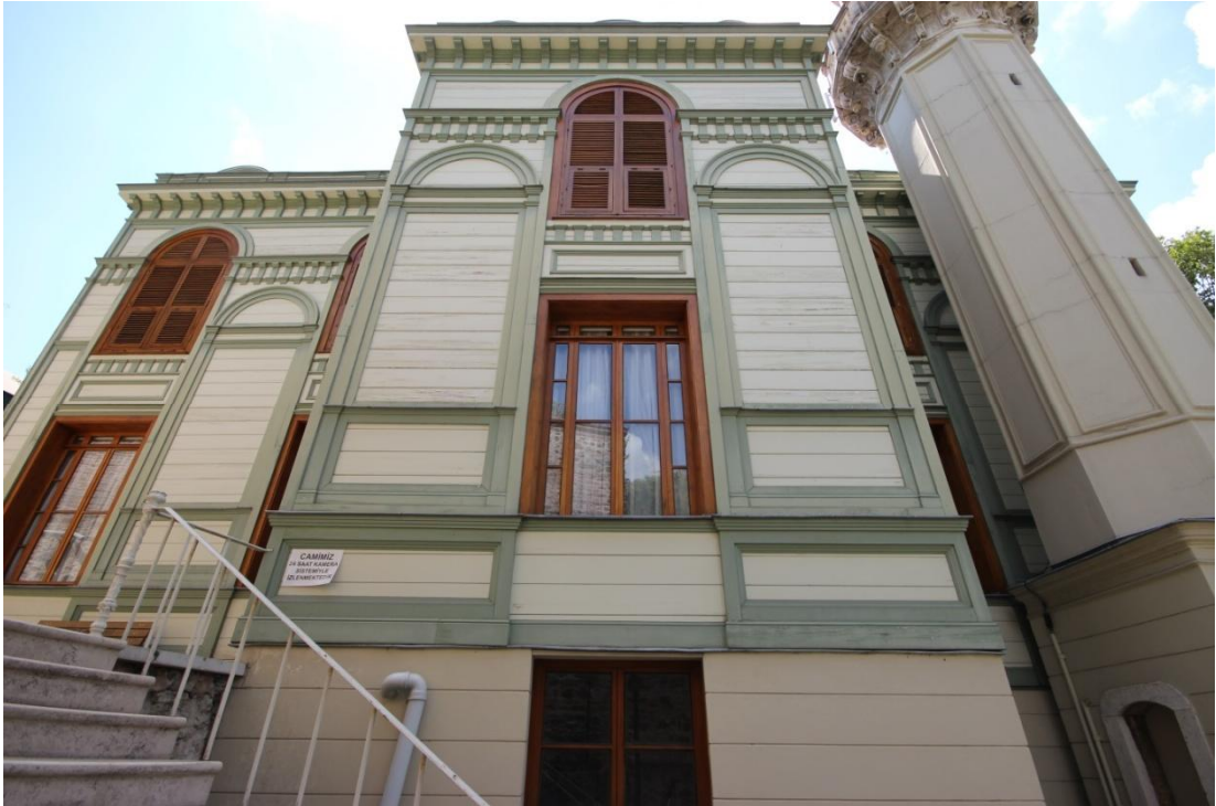
Resim 4: İstanbul, Beşiktaş, Ertuğrul Tekke Camii Kuzey Cephesi.
