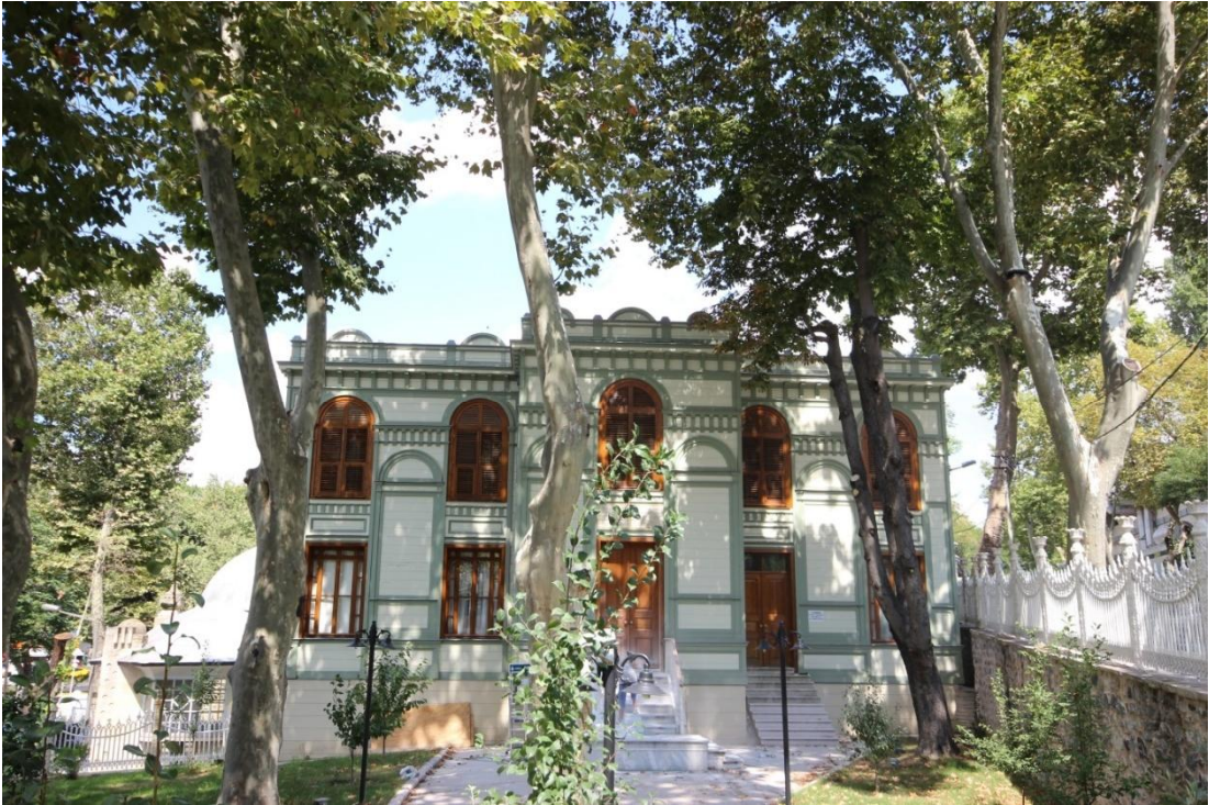
Resim 8: İstanbul, Beşiktaş, Ertuğrul Tekke Camii Güney Cephesi.
