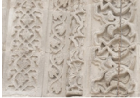
Görsel 9. Erzurum Çifte Minareli Medrese taç kapısındaki kompozisyon-derz ilişkisinde yapılmış iki bordür
