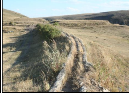
Fotoğraf 2. Karayolu çalışmalarının ardından tahrip olan su kanalı (Eylül 2011).
