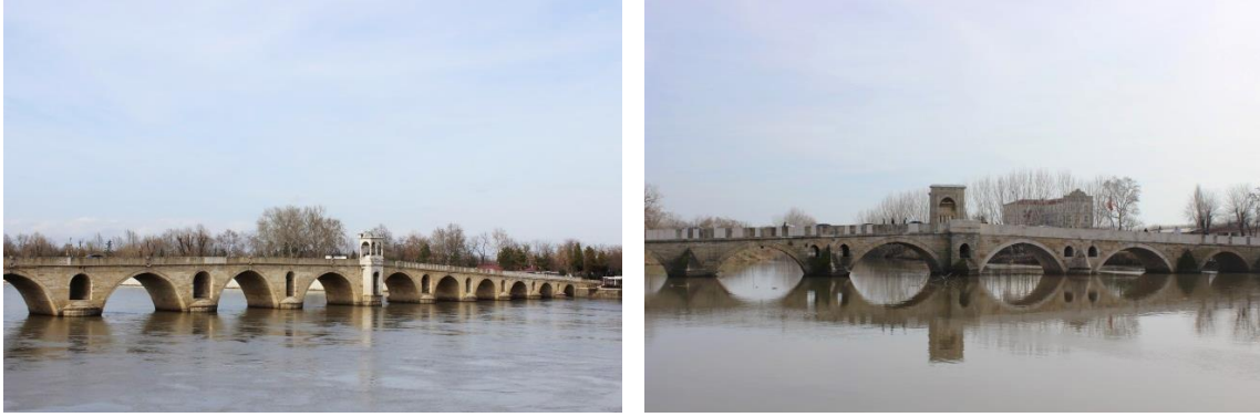
Şekil 4. Meriç Nehri-Köprüsü ve Tunca Nehri-Köprüsü
