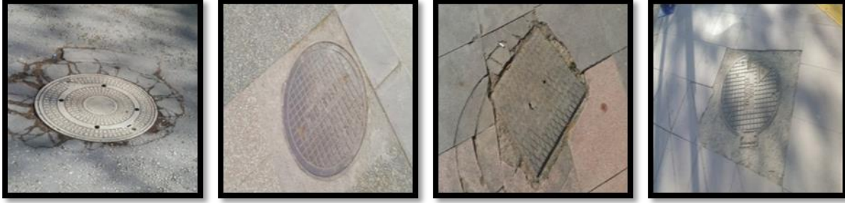
Şekil 18. Alparslan Türkeş Caddesi üzerinde yer alan alt yapı tesisleri bakım kapakları
