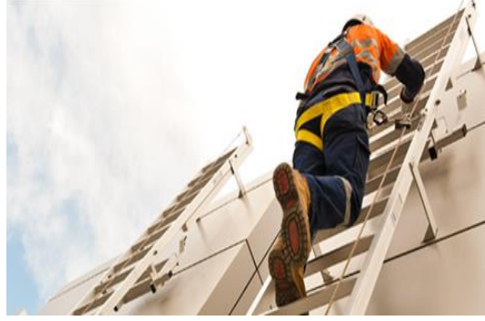
Şekil 3: Merdiven ve basamaklarda güvenli çalışma örneği
