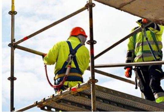
Şekil 5: İskele montajı güvenli çalışma örneği
