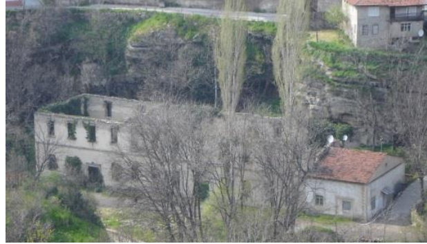
Şekil 2.Tabakhane Binasının günümüze ait genel bakış
