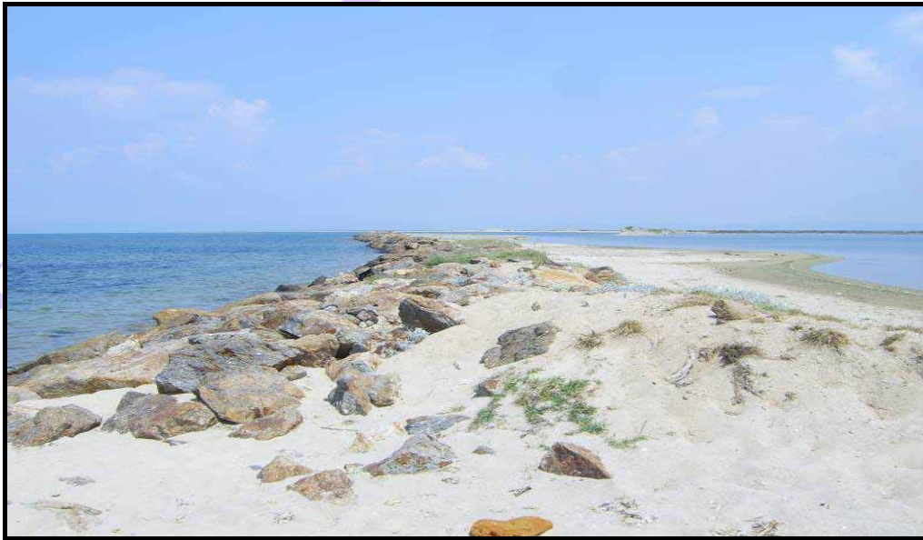
Foto 1: Bücürmene (Işık) Lagün Gölü Kıyı Okunun Erimesinin Önüne Geçmek İçin Blok Kayalarla Dalga ve Akıntılara Karşı Koruma Altına Alınmıştır
