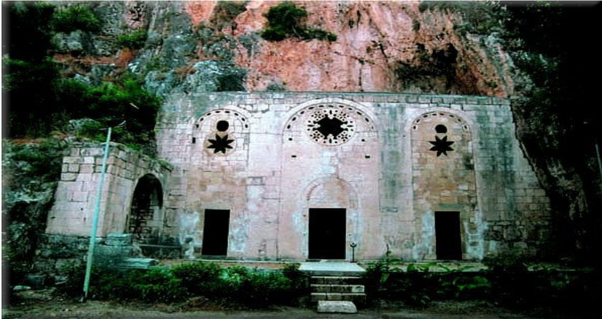
St. Piyer Kilisesi (Bugünkü durumu)
