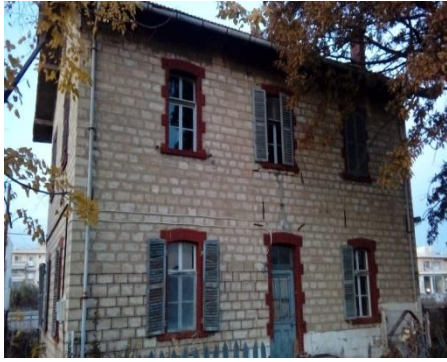
Fotoğraf 42: Tren İstasyonu yönetim binası
