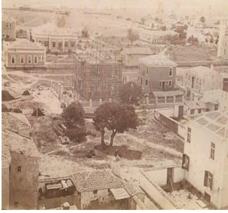
Fotoğraf 179: Dedeğaç hükümet binası inşa edilirken ve sağ tarafta Camii
