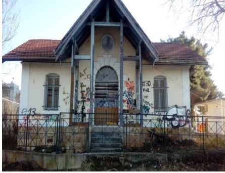
Fotoğraf 47: Askeri İstasyon ana cephe
