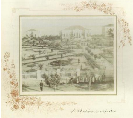
Fotoğraf 173: Dedeğaç hükümet konağı ve solda Camii
