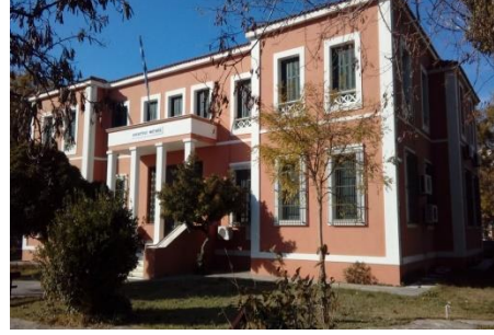
Fotoğraf 38: Dedeğaç Hükümet binası güney- doğu cepheleri
