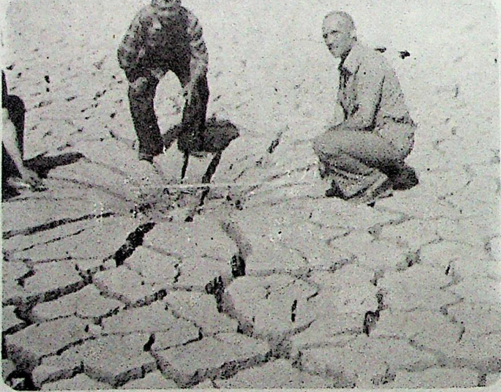
FOTO: 6- Sille Barajı rezervuar alanı tabanında oluşan bir düden. Sille barajı rezervuar alanında volkanitlerin yaygın ve kalın olduğu bilinmektedir. Bunların alterasyonu sonucu oluşan killi zemin geçirimsiz olmakla birlikte volkanitler dolomitik kalkerleri diskordant olarak örtmüş ve hatta yer yer kalkerlerden oluşan prevolkanik arazi aflöre edilmiştir. Bu sebeptendir ki, yeraltı sularının kalkerli arazideki etkileri sonucu Sille Baraj Gölü tabanında düdenler oluşmuş ve su kaçakları vuku bulmuştur. Fotoğrafta kuruyan baraj gölü ve buna sebep olan düdenlerden biri ile kuruma çatlakları görülmektedir (2 Ağustos 1986)
