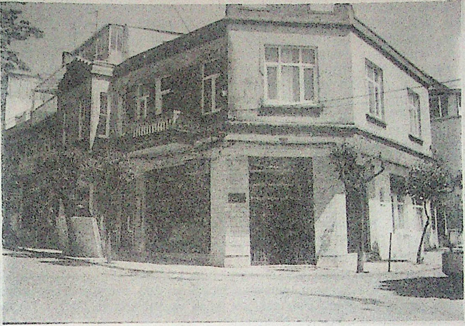
Foto 6 : Adanın Tarihi Mimarisiyle Ters Düşen Betonarme Bir Yapı
