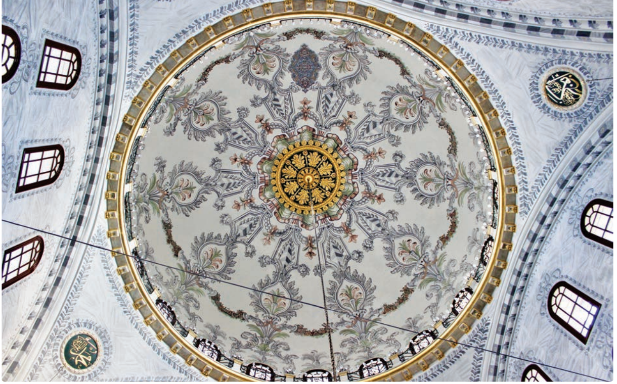
Fotoğraf 22: Nusretiye Camii kubbesi ve intikal elemanları.
