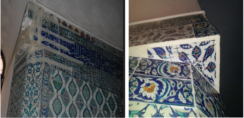
Foto. 32-33: Restorasyon Öncesi Ve Sonrası Yapı İçinde Bulunan Çinilerin Durumu.
