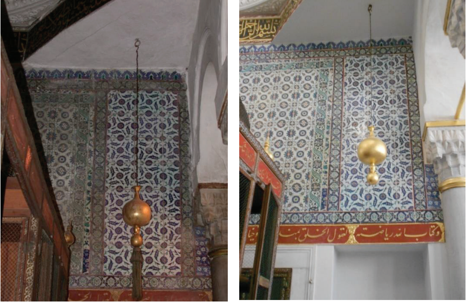
Foto. 34-35: Restorasyon Öncesi ve Sonrası Yapı İçinde Bulunan Çinilerin Durumu.
