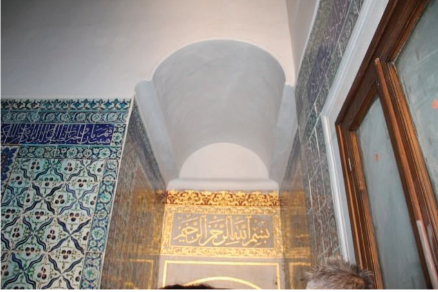
Foto. 19: Restorasyon Sonrası Koridor Yönünden Hazine-İ Kütüb Kapısının Üstünde Yer Alan Mermer Kitabenin Temizlenmesi Ve Varaklanmasının Ardından Durumu.
