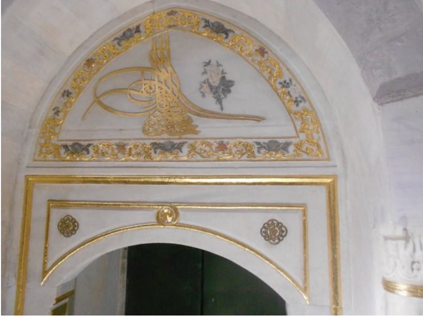
Foto. 25: Restorasyon Sonrası Hazine-İ Kütüb Bölümünün Kapısı Mermer Temizliği Ve I.Mahmud Tuğrası Ve Çevresin Altın Varak Yapılmasının Ardından Durumu.
