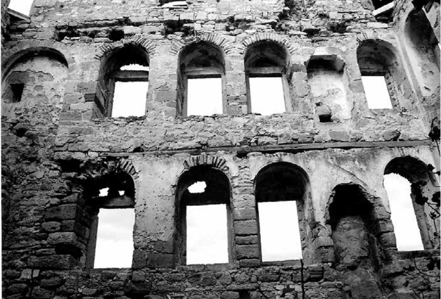
Res.14. İç kuzey cephe
