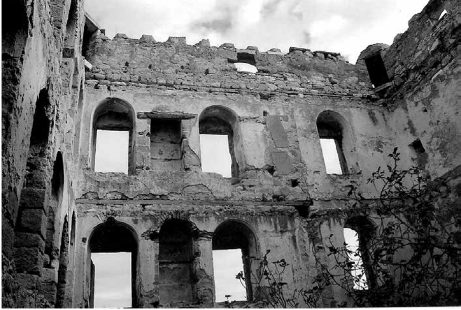
Res.13. İç dođu duvarı
