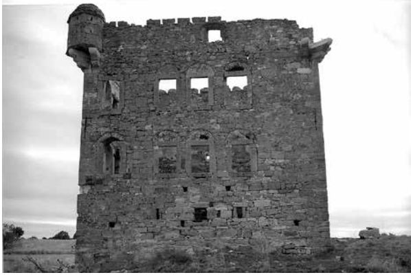
Res.8. Konağın kuzey cephesi
