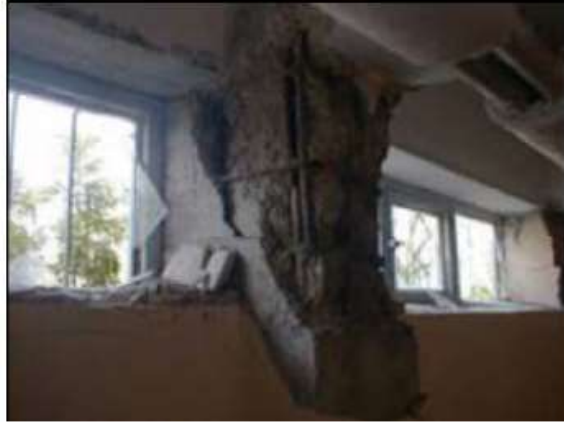
Şekil 12. 1999 Düzce depreminden sonra bir okulda gözlenen kısa kolon hasarları (İrfanoğlu (2009)).
