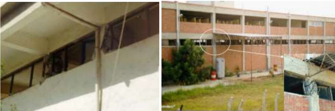
Şekil 11. (a) Kısa kolon etkisi ile hasar gören bir yapı, Adapazarı depremi. (b) Kısa kolon etkisi ile hasar gören bir yapı, Ceyhan depremi (Çağatay (2007)).
