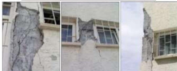
Şekil 13. 1 Mayıs 2003 Bingöl depreminden sonra kısa kolon davranışının da etkisiyle hasar gören okul binaları (İrfanoğlu (2009)).
