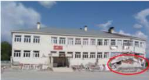
Şekil 13. 1 Mayıs 2003 Bingöl depreminden sonra kısa kolon davranışının da etkisiyle hasar gören okul binaları (İrfanoğlu (2009)).
