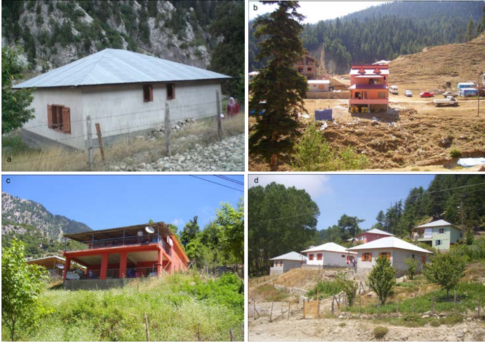
Foto: 6. Günümüzde yaylaların hemen hepsinde aynı özelliklerin kullanıldığı briket duvar ve sac örtülü meskenler yaygındır. Elmacık (a), Kayapınarı (b), Elifosmanınağılı (c), Demircikbucağı (d) yaylaları modern yapıli meskenlere en güzel örnekleridir.
