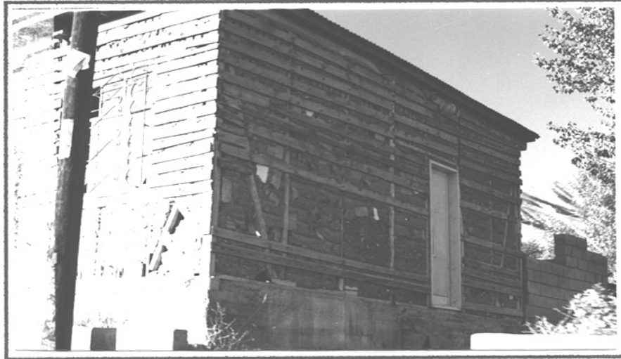
Foto 5 : Çukurkuyu Köyü'nde, inşası tamamen bitirilmiş ve kullanılmakta olan bir çakatura dolma meskenin yakından görünüşü.
