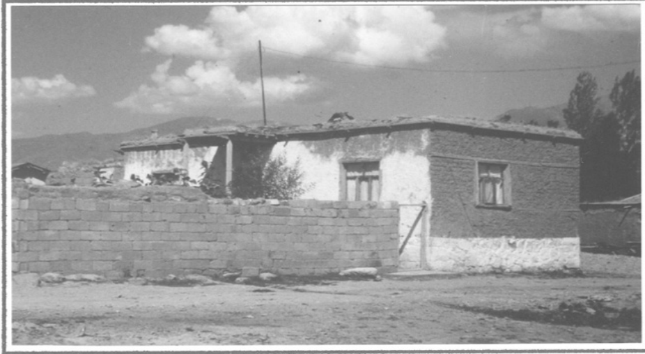
Foto 1: Ova tabanında yer alan Denizdamı Köyü'nden bir kerpiç mesken örneği. Yüksek taban suyundan etkilenmemek amacıyla, taş temel üzerine inşa edilmiş bu mesken tipine, ova tabanında oldukça sık rastlanmaktadır. Genelde bir girişi ve iki odası bulunan bu meskenler, planları itibariyle de standarttır.
