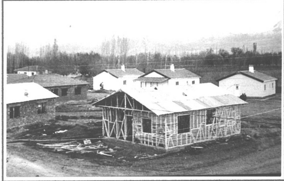
Foto 4: Uluköy'de, ahşap iskeleti tamamlanmış bir çakatura dolma mesken örneği. Bu tip meskenler, malzemesinin hafifliğine bağlı olarak, deprem bakımından nispeten daha elverişlidir. Buna rağmen, sayıları oldukça azdır
