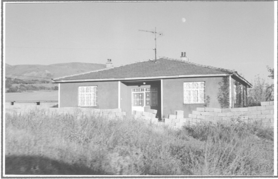
Foto 2: Günebakan Köyünde, inşasında tuğla kullanılmış olan, modern bir kır meskeni
