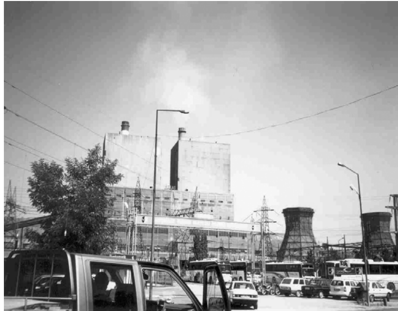
Foto. 9. Kurumalarda etkili olduđu düşünölen termik santrallerden Tunçbilek termik santrali.
