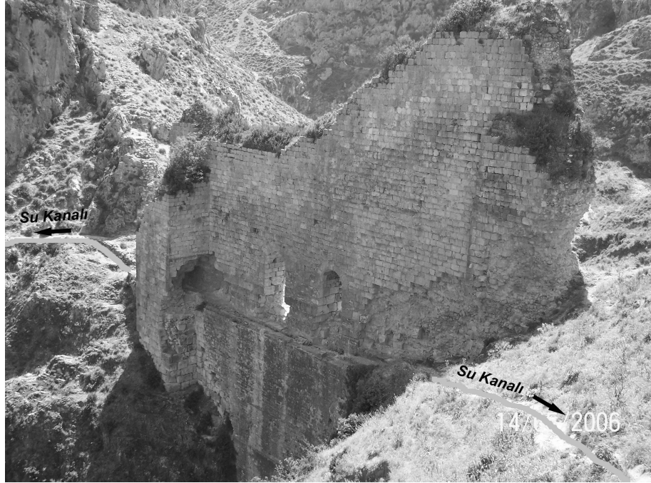
Foto 1. Parmenius (Hacı Kürüş) Deresi üzerine, hem taşkınlardan korunmak hem de kış sularını depo etmek amacıyla yapılan bent.
