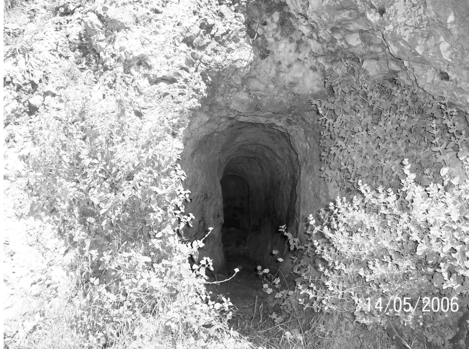
Foto 2. Parmenius Vadisi yamacında Eosen kalkerleri içinde açılan tünel kanal.
