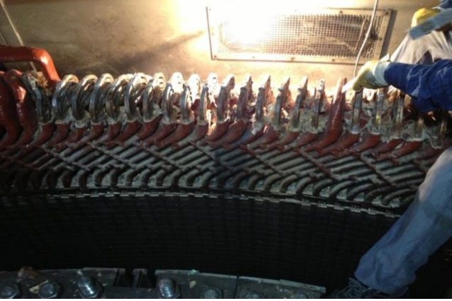
Şekil 2. Stator sargı demontajı
