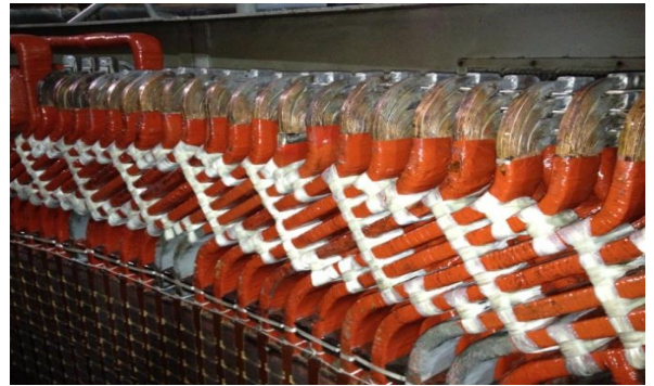
Şekil 6. Stator sargılarının montajı
