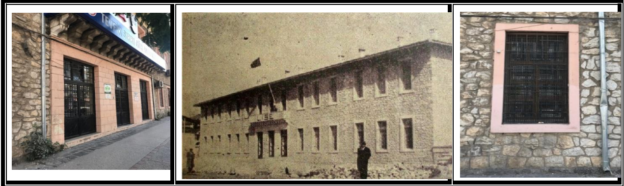
Şekil 14: Mersin Lisesi olarak açılan sonradan Mersin Tevfik Sırrı Gür Lisesi adını alan eğitim binasının giriş cephesi ve detayları (Kaynak: www.wowturkey.com.tr )
