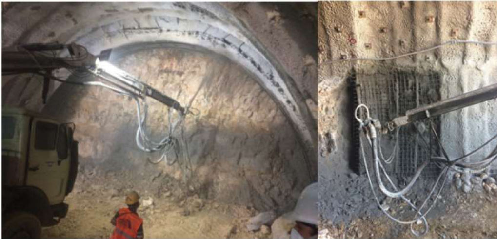
Şekil 4. İksa ve çelik hasır arasına püskürtme beton atılması
