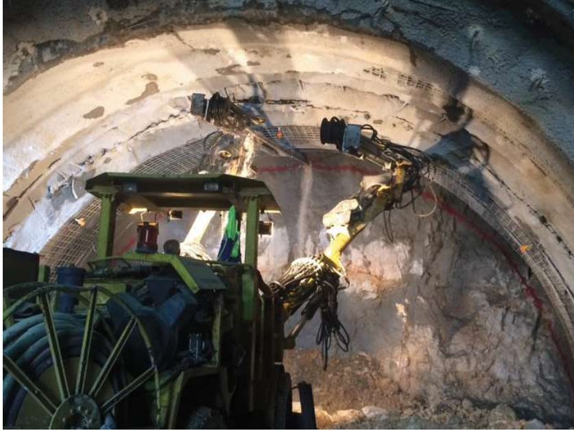
Şekil 3. Jumbo ile robbit delgisi
