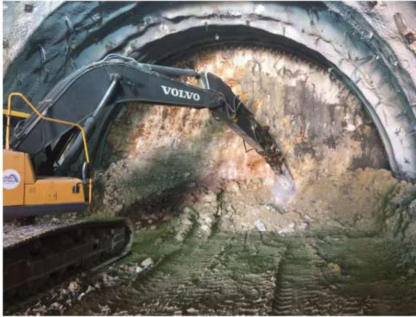
Şekil 2. Tünelde hidrolik kırıcı ile kazı işlemi
