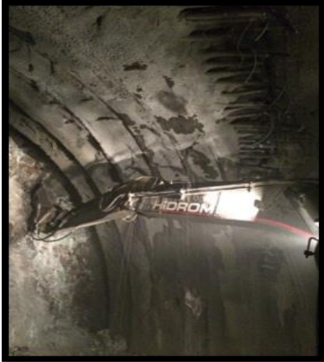
Şekil 4. T-5 tüneline enjeksiyonları tamamlanmış robotlar ve kazı aşaması
