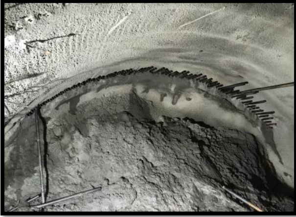
Şekil 3. T-5 tüneline robot uygulaması tamamlanmış ama enjeksiyonları yapılmamış robotlar
