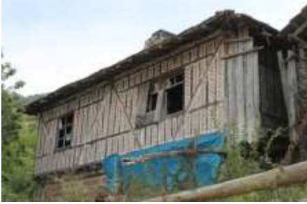
F.23.Şahinkaya Köyü 9 Nolu Ev
