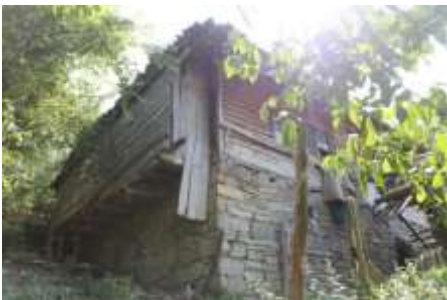
F.21. Şahinkaya Köyü 7 Nolu Ev
