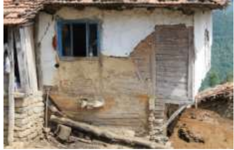
F.34. Meşelitürkmenler Köyü 3 Nolu Ev
