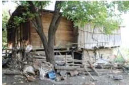
F.22. Şahinkaya Köyü 8 Nolu Ev
