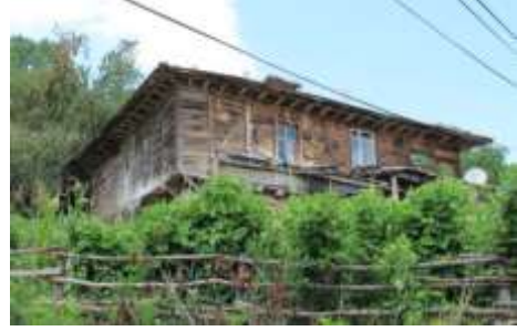
F.32. Meşelitürkmenler Köyü 1 Nolu Ev
