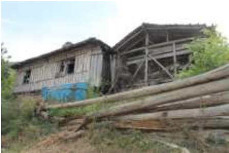
F.19. Şahinkaya Köyü 5 Nolu Ev
