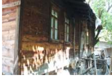
F.18. Şahinkaya Köyü 4 Nolu Ev
