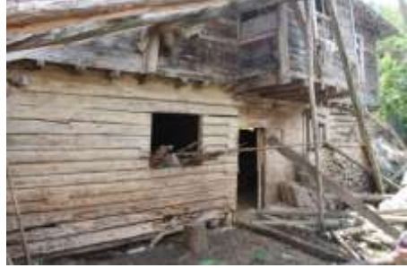
F.16. Şahinkaya Köyü 2 Nolu Ev
