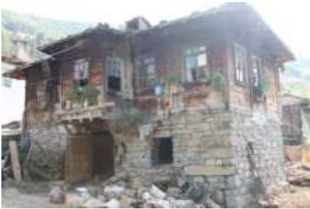
F.17. Şahinkaya Köyü 3 Nolu Ev
