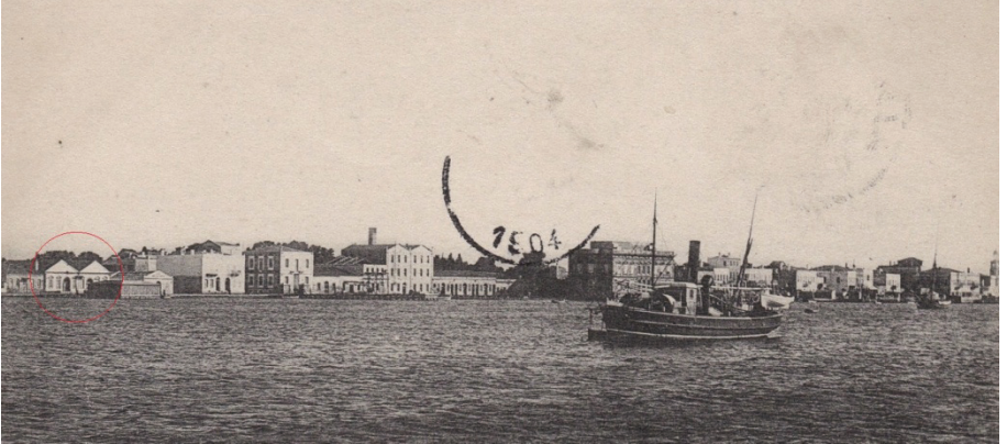
Res. 10: Whittall Konağı'nın yerinde bulunan yapılar. (1904). (ÇKM Arşivi).
