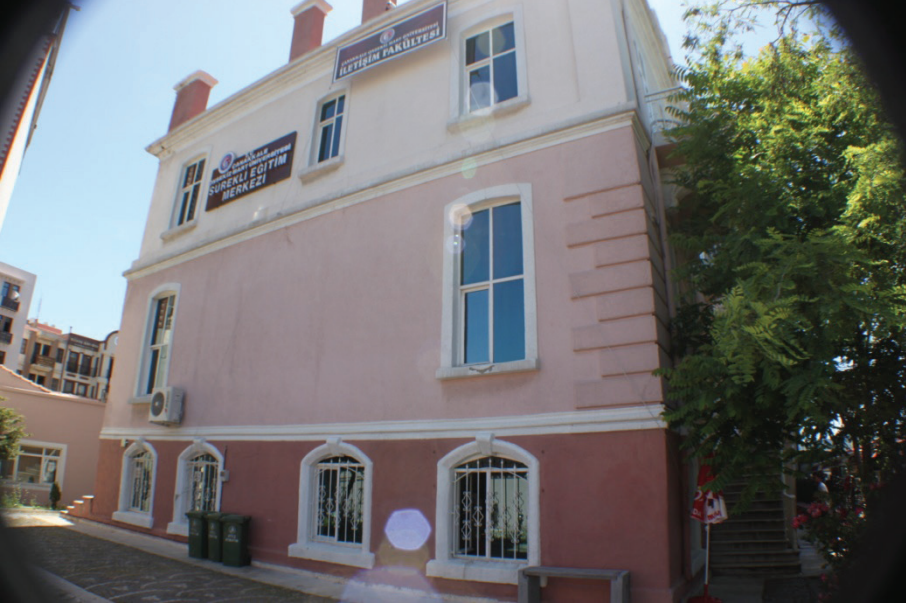
Res. 7: Vitalis Konağı, doğu cephe. (2013).
