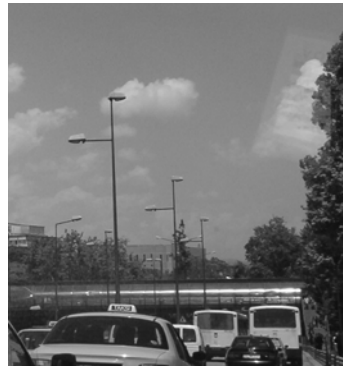
Şekil 14. Kavşak tipi aydınlatma elemanı (çiftli) (Tip 9) (Junction lighting element double Type 9)
