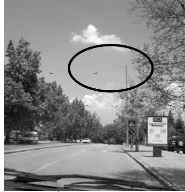
Şekil 13. İki cephe arası bağlayıcı aydınlatma elemanı (Tip 8) (Lighting element related two facades Type 8)
