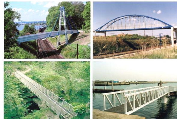
Şekil 2. CTP profillerle üretilmiş hafif yapı örnekleri [5] (Examples of lightweight structure constructed using GRP profiles [5])
